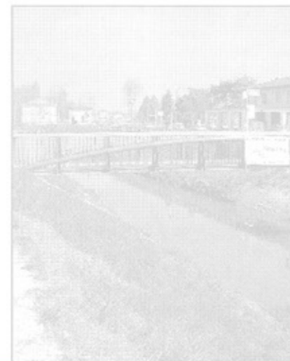
La nuova passerella a Torre di Burri
